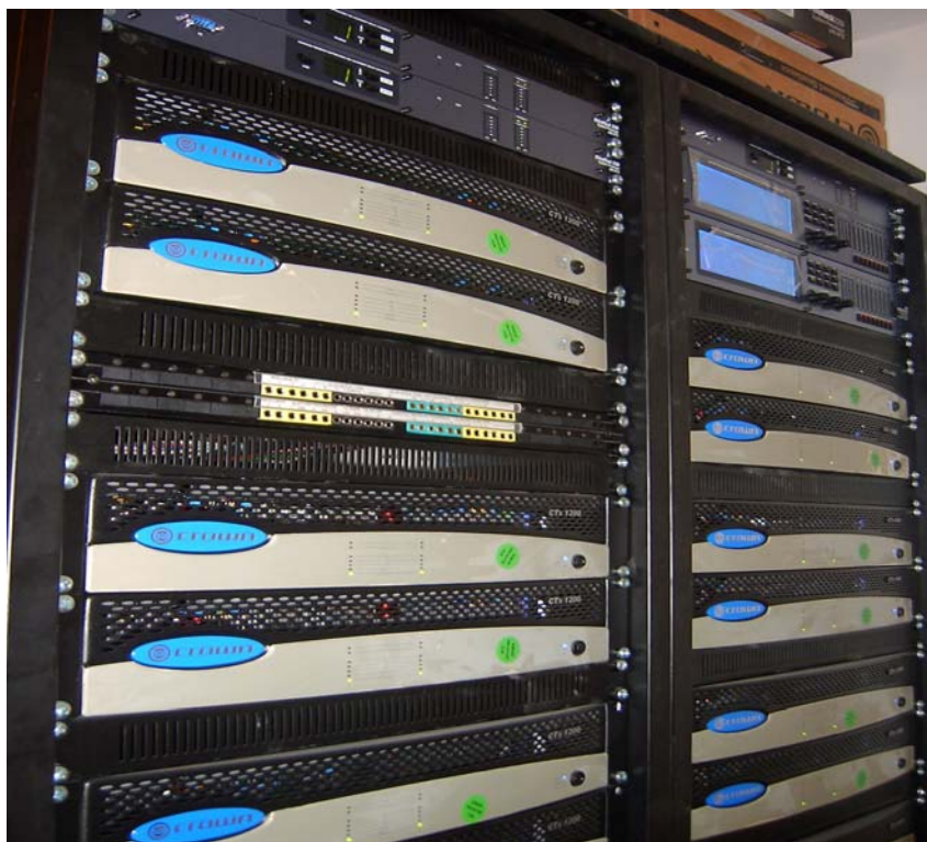
Slika br. 5 – Pojačavači snage i digitalni procesori u ormarima 19"
